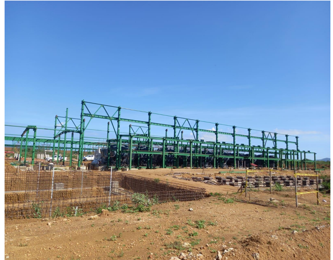
CENTRAL ELÉCTRICA INSTALACIÓN DE ESTRUCTURAS DE ACERO
