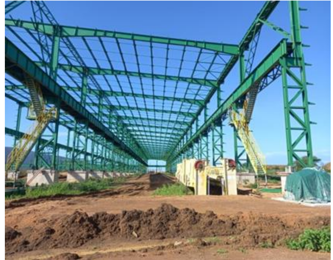
PLANTA DE LAMINACIÓN, EMPLAZADO DE LOS PUENTE GRUA PARA SU INSTALACIÓN
