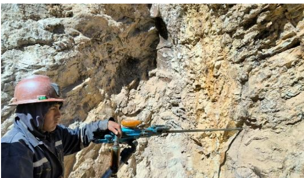
Fotografía N°2. Desarrollo en la Mina San Bartolomé Sector Negrillos. Equipado en la gestión 2024, con maquinaria y equipo para interior mina.
