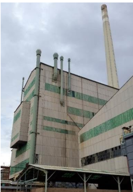
Fotografía 1. Nave N°3 de fundición de Pb-Ag.
