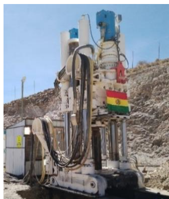
Fotografía 3. Equipo de perforación Raise Boring.
