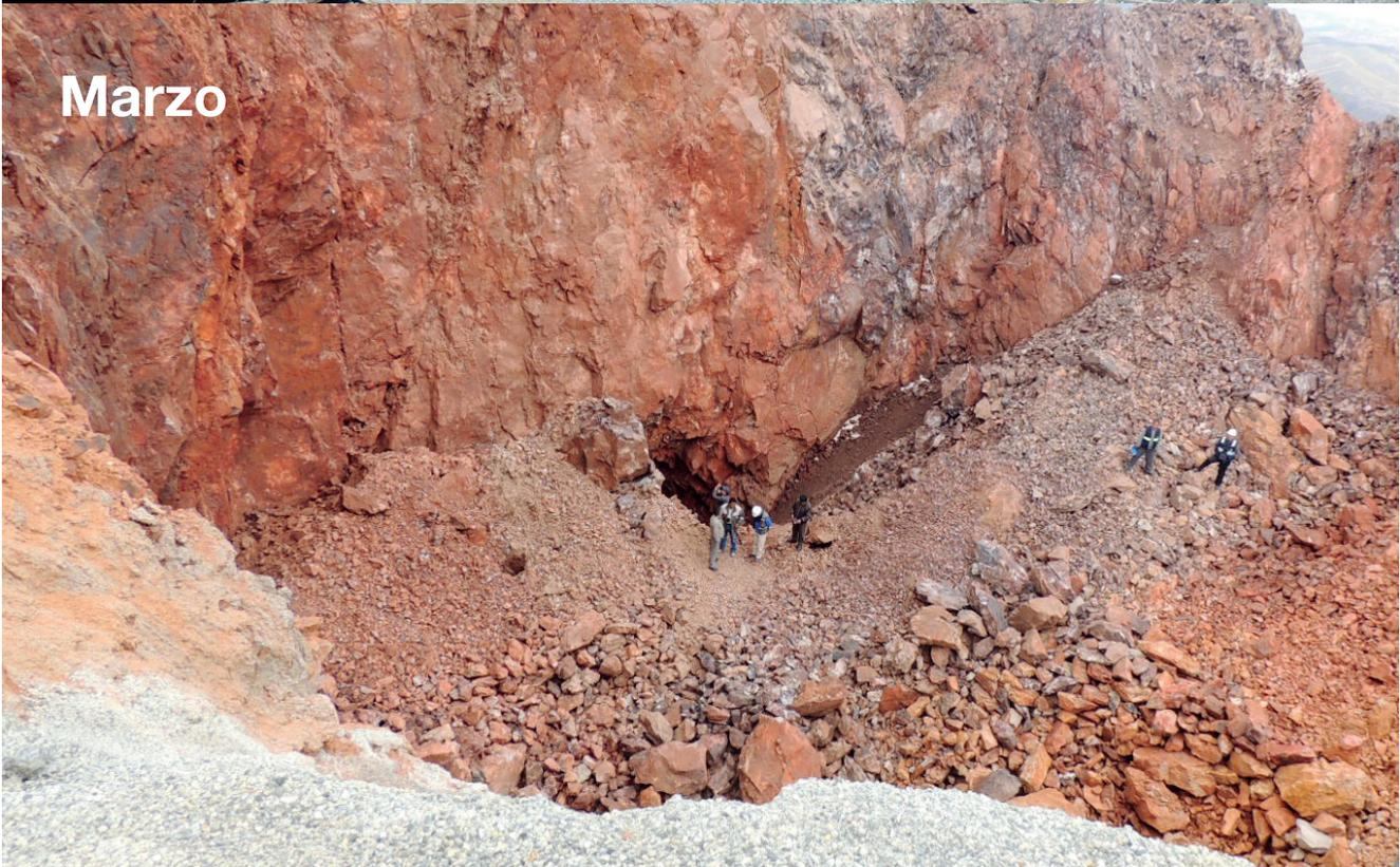
Factores climáticos, inestabilidad del terreno generado por el hundimiento y la alta fracturación de la roca provocaron, y continuarán provocando, mayor desprendimiento lateral que ya hizo desaparecer el relleno de hormigón aligerado.
