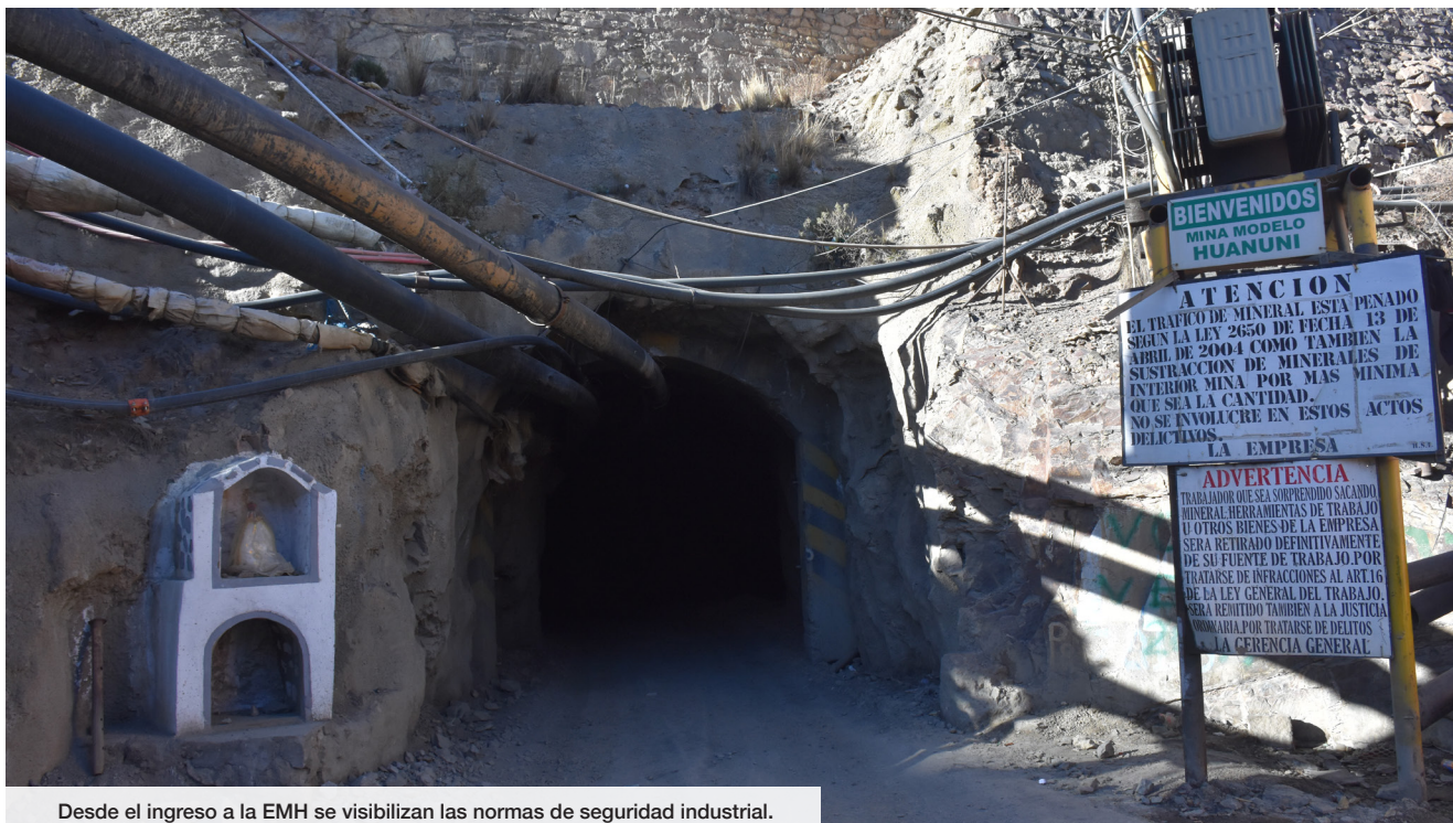
Desde el ingreso a la EMH se visibilizan las normas de seguridad industrial.
